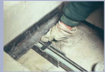
图 3: 质量弹簧系统的支承垫的定位
